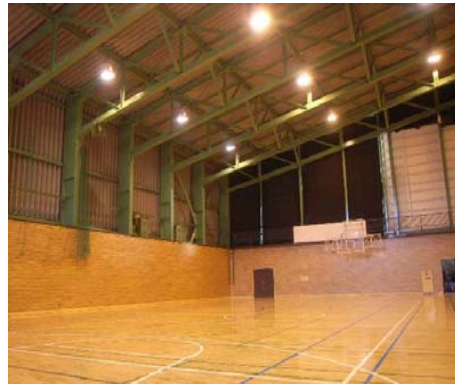
耐震改修が完了した体育館
