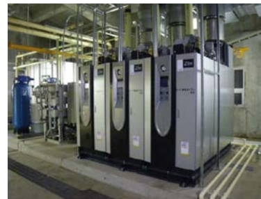
設備機械棟暖房用ボイラー設備改修工事
