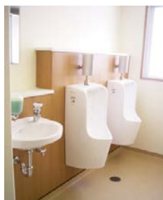
単身用学生宿舎トイレ改修工事
